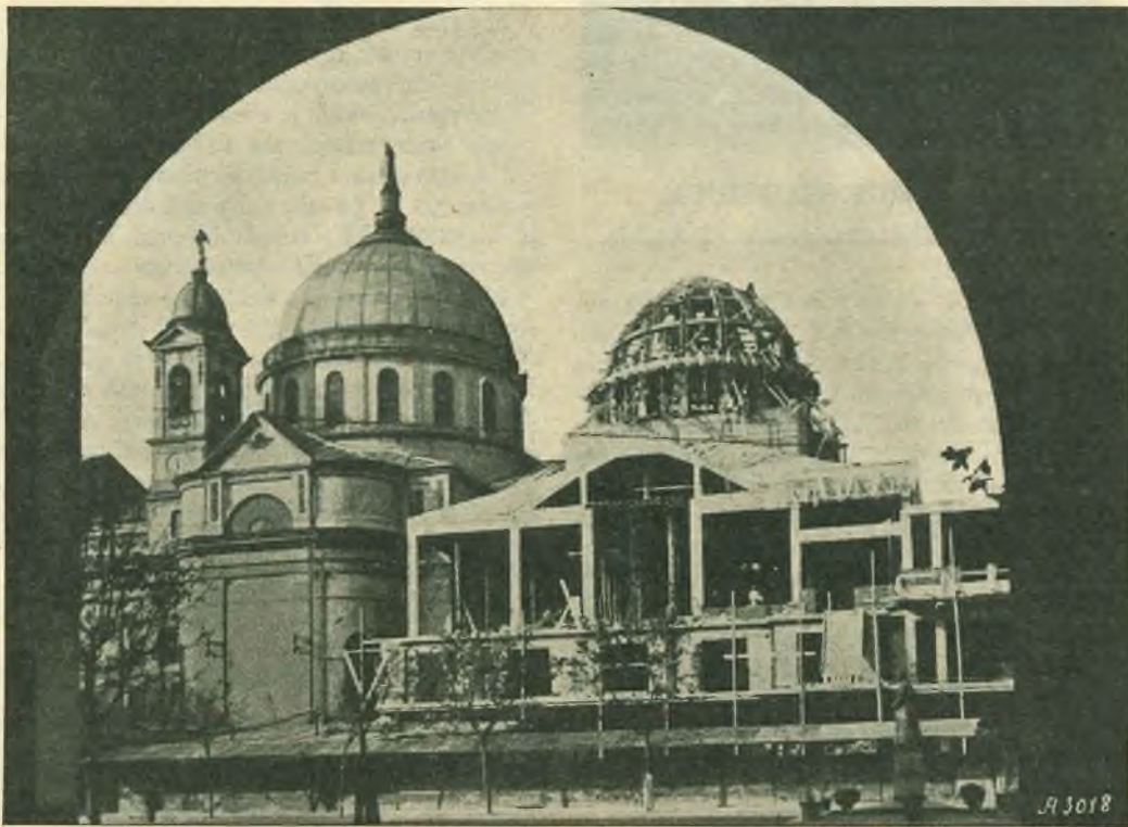
Il progresso dei lavori nel mese di ottobre.
